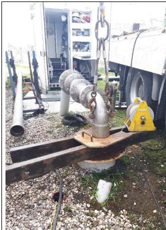
Forage de Lagravette à Lafitte sur Lot
